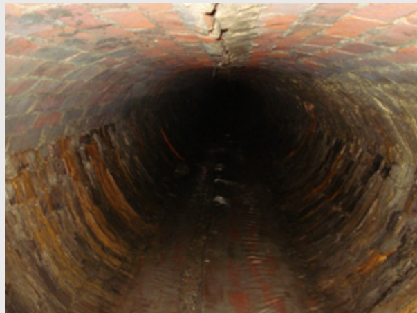
Bild 7: Erheblicher Längsriss im Scheitel und in der Sohle, stark deformierter Querschnitt
