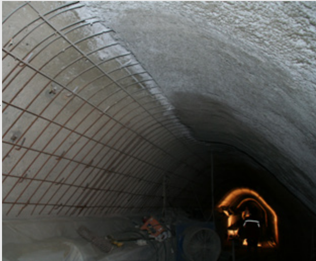
Bild 12: Bewehrung der Spritzbetonschale
