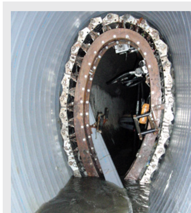
Bild 11: SPR-Wickelrohrvorgang
